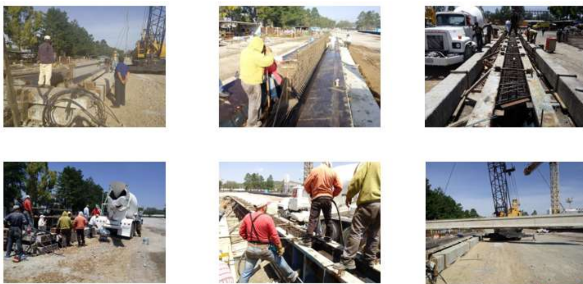
Fig. 52. Ejemplo de traveses prefabricados tipo AASHTO (por cortesía de la empresa "CASA LEAN").
